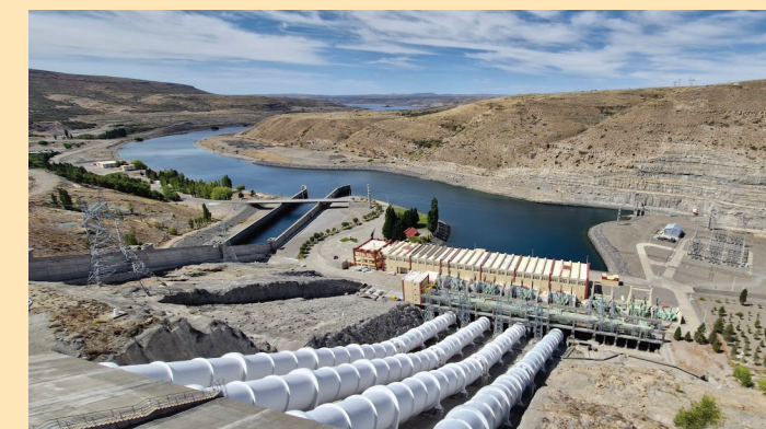
Vista desde obra toma de agua
