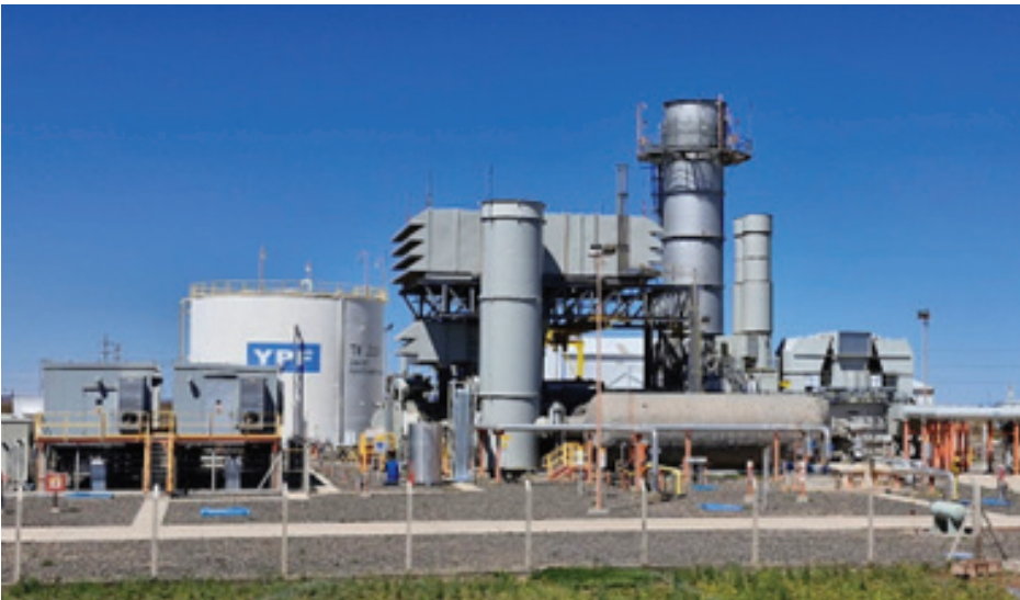
Vista de la Central Loma Campana I y II
