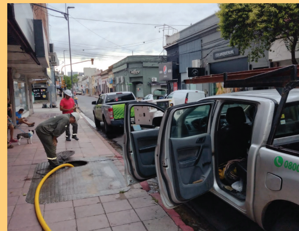
Héctor Luis Almirón, Subestaciones Eléctricas, DPEC Corrientes, realizando tareas en zonas afectadas por inundaciones
